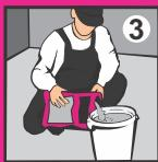
Для подготовки раствора залейте водопроводную воду комнатной температуры в чистую ёмкость из расчёта 5,0 - 5,7 л воды на 1 мешок (25кг).
