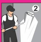
Обработайте основание грунтовочными составами БОЛАРС, соответствующими Вашему типу поверхности.
